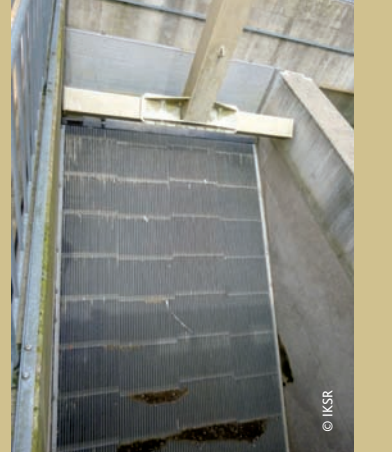
Rechen sollen Fische von Wasserkraftturbinen fernhalten.
