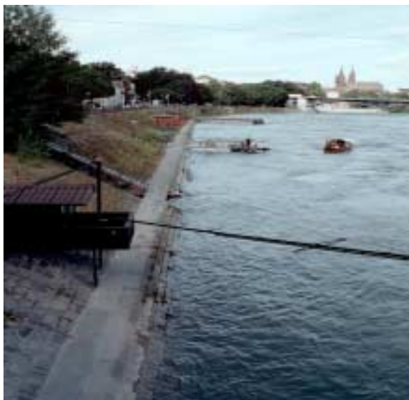
Rhin à hauteur de Bâle, PK 165 (situation typique du fleuve canalisé dans une agglomération) Source : HYDRA Berne, V. Maurer, 2001
