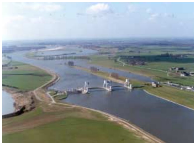
Retenue sur le Nederrijn à hauteur d'Amerongen (PK 922, photo : RWS(MD))
