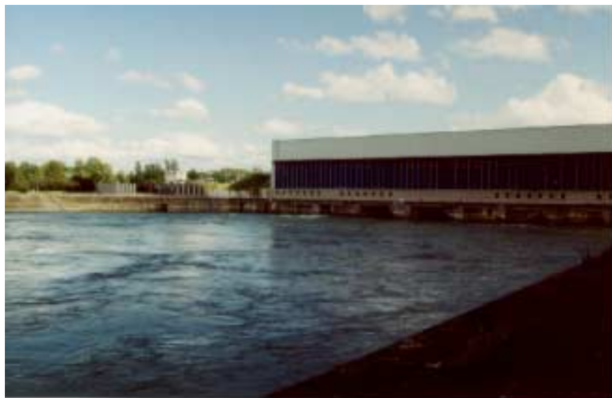
Rhin canalisé, entrée de l'usine hydroélectrique (source: Agence de l'Eau Rhin-Meuse)
