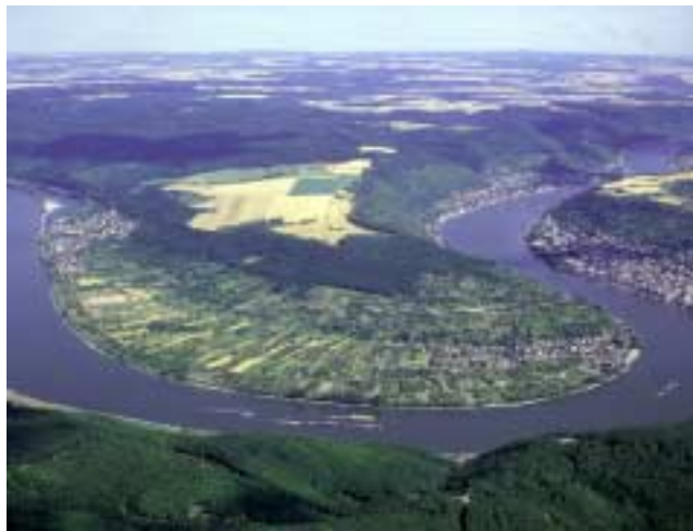
Boucle du Rhin à hauteur de Boppard, zone de développement pour rives et plaine alluviale, zone caractérisée par l'habitat et les usages, 1986, source : LMZ RP/G. Rittstieg
