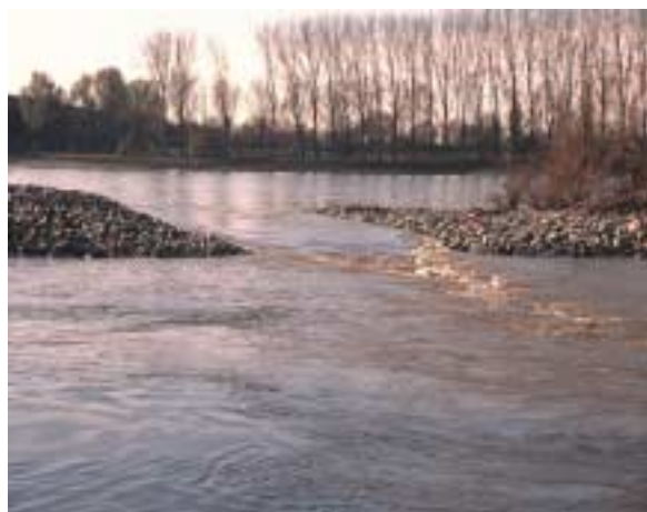
Mise en place d'une connexion ouverte, Altrhein Ballauf à hauteur de Mannheim, Source : LfU B.-W., Steinmetz
