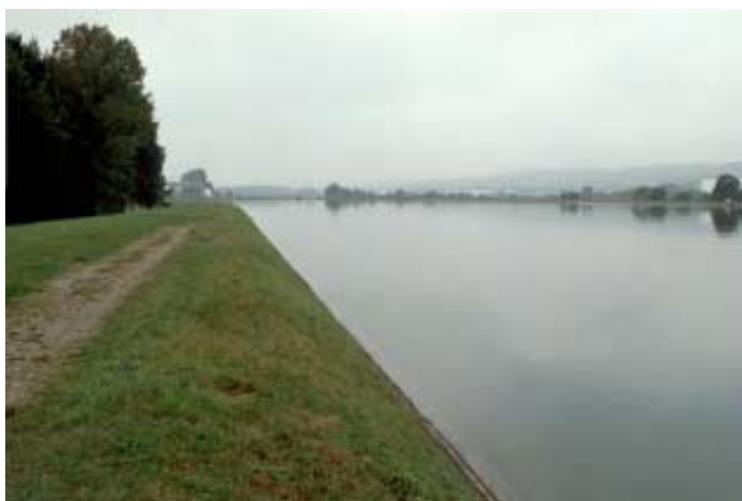
Espace de rétention Albruck-Dogern, PK 108 (situation typique des rives artificielles dans les zones de rétention sur le haut Rhin) Source : HYDRA Berne, V. Maurer, 2001
