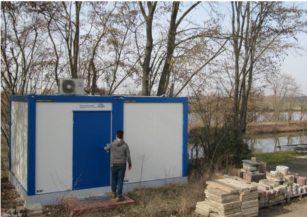
Foto 2: Messstation Kahl am Main (Wasserwirtschaftsamt Aschaffenburg), Bayern
