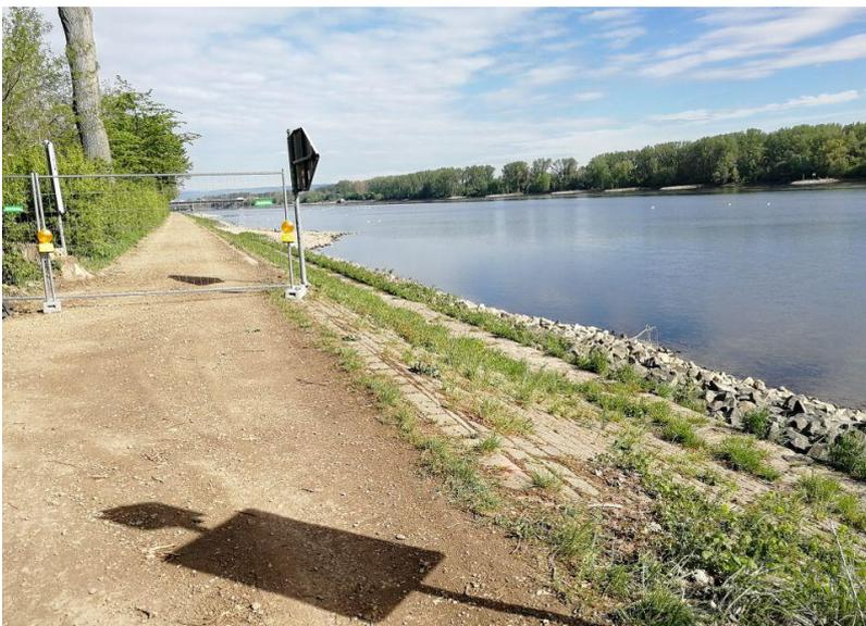
**Abbildung 19:** Ausgangssituation – ein über weite Strecken gepflastertes Deckwerk
