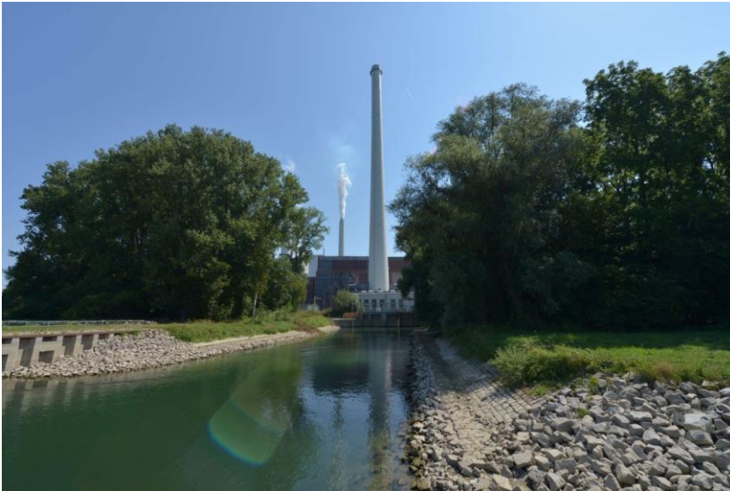
Foto 6: Stoomkrachtcentrale aan de Rijnhaven (EnBW), van de Rijnsoever tot de koelwateruitlaat (bron: LUBW)
