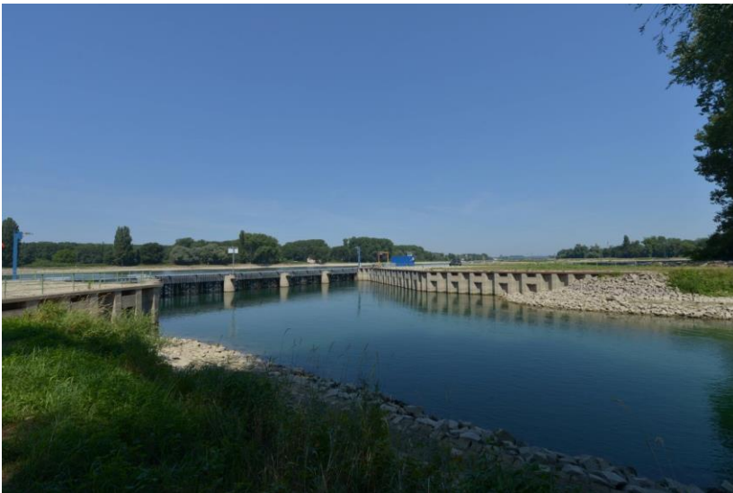
Foto 7: Koelwateruitlaat van de stoomkrachtcentrale aan de Rijnhaven (EnBW) met grofvuilrooster, uitgang aan de Rijn richting westen (bron: LUBW)
