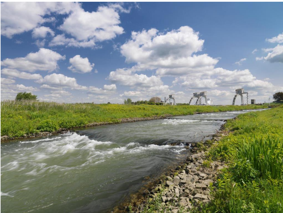
Foto 4: Stuw Hagestein op de Lek, complex van stuw en sluis, dat mede bijdraagt aan de regulering van de waterhuishouding in Nederland (bron: Tineke Dijkstra)
